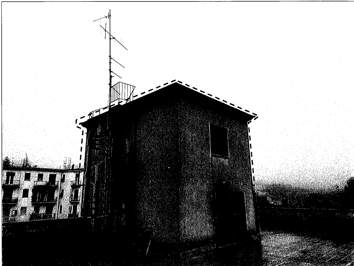
VEDUTA GENERALE DELL'IMMOBILE 1
