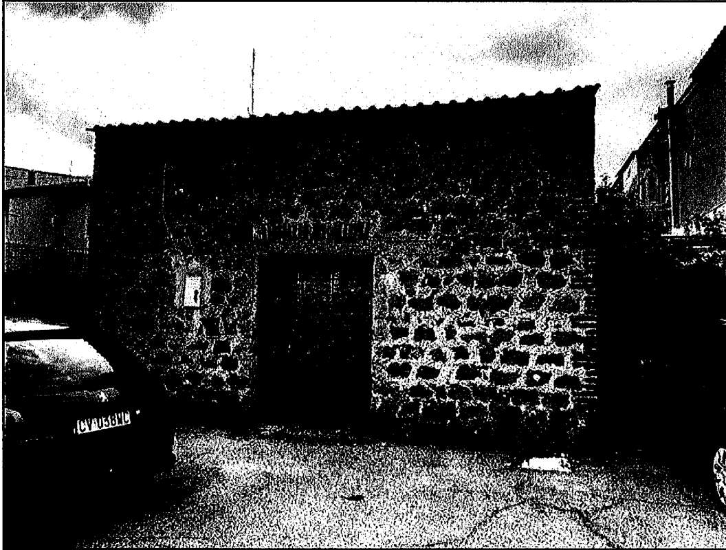
VEDUTA GENERALE DEL FABBRICATO
