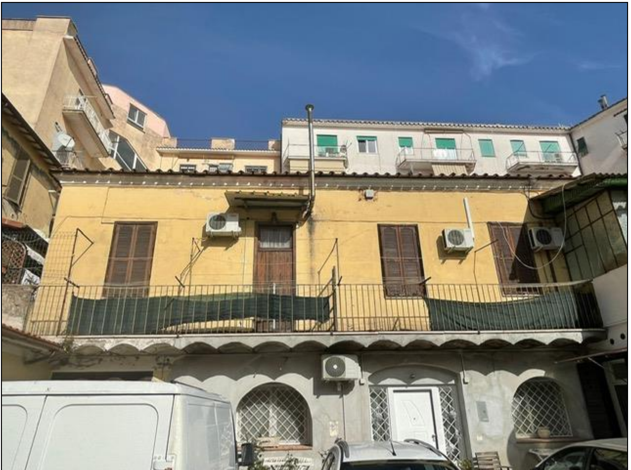
VEDUTA GENERALE DELL'IMMOBILE 1
