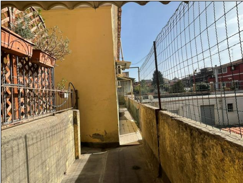
VEDUTA GENERALE DELL'IMMOBILE 2
