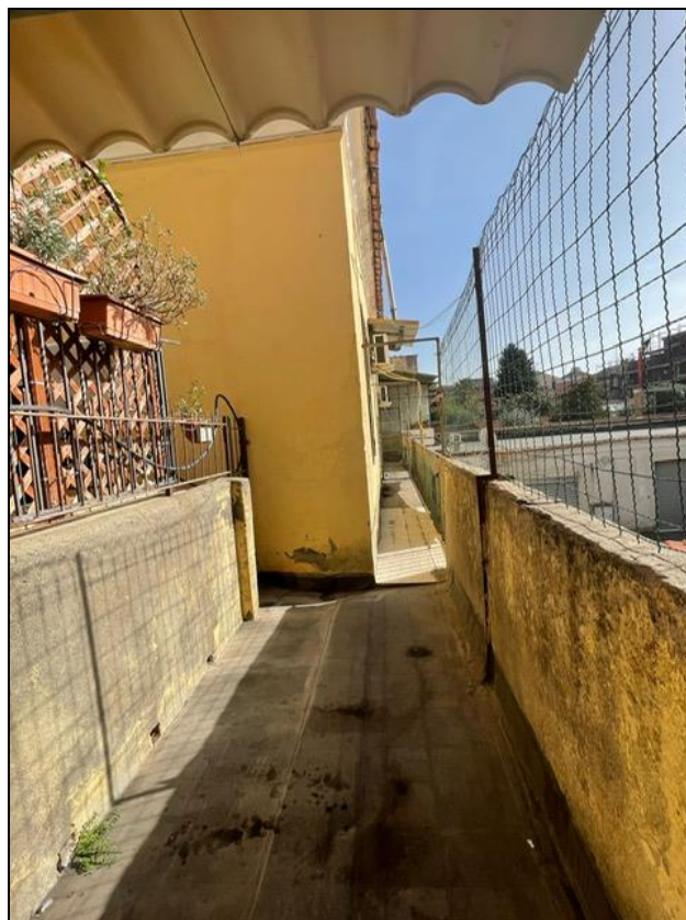
VEDUTA GENERALE DELL'IMMOBILE 3
